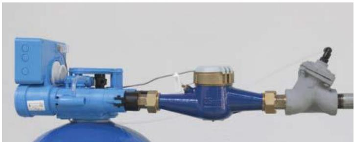
Statiile de dedurizare **AS/Meter** includ un debitmetru cu emitor de impulsuri cu cadran uscat cu totalizator si o vana cu membrana cu comanda hidropneumatica, pentru a intrerupe alimentarea cu apa netratata in timpul regenerarii.
