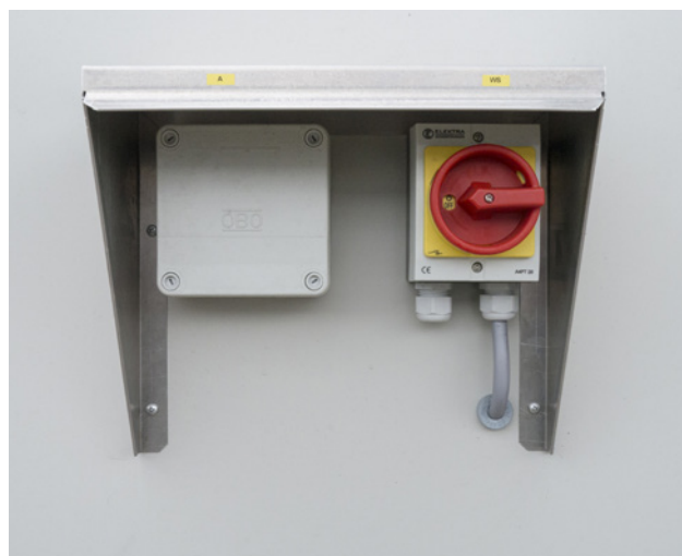
Comutator izolator.
