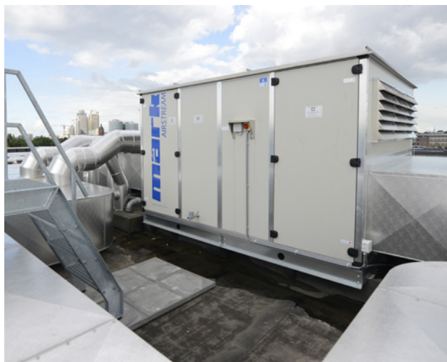
AIRSTREAM unitati de recuperare a caldurii pentru instalarea in exterior.
