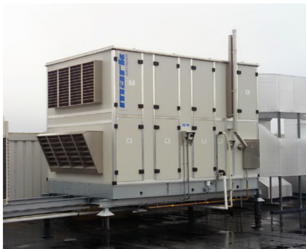
AIRSTREAM unități de recuperare a căldurii pentru instalarea în exterior.
