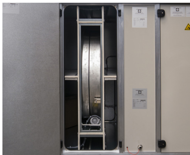
Schimbator de caldura rotativ in unitatea (vedere laterala).
